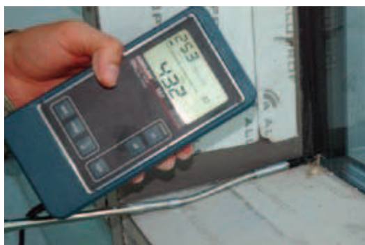
Wykryta nieszczelność w narożniku fasady
