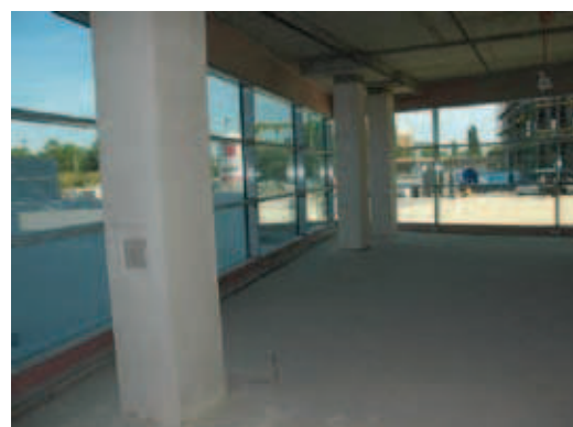
Fasada słupowo-ryglowa
